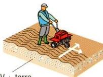
4. Pour les talus, travailler le sol avec TEV sur une profondeur de 20 cm à l'aide d'une pelle.
