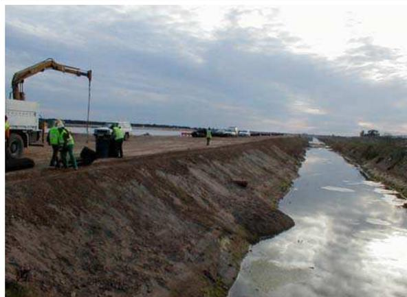
Commencer par le haut du talus en ancrant la partie supérieure avec une agrafe tous les 20 cm enfoncée sur un minimum de 20 cm. Prévoir une languette d'un mètre en haut du talus. Une fois les agrafes posées, remplir de terre végétale et tasser. Les agrafes doivent être adaptées à la typologie du terrain. Le nombre d'agrafes conseillé au m<sup>2</sup> est de 1 à 1,5.
