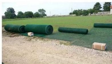
Déroulez la grille TYPE 8 sur la zone à renforcer et fixer une extrémité avec des attaches métalliques en U.
